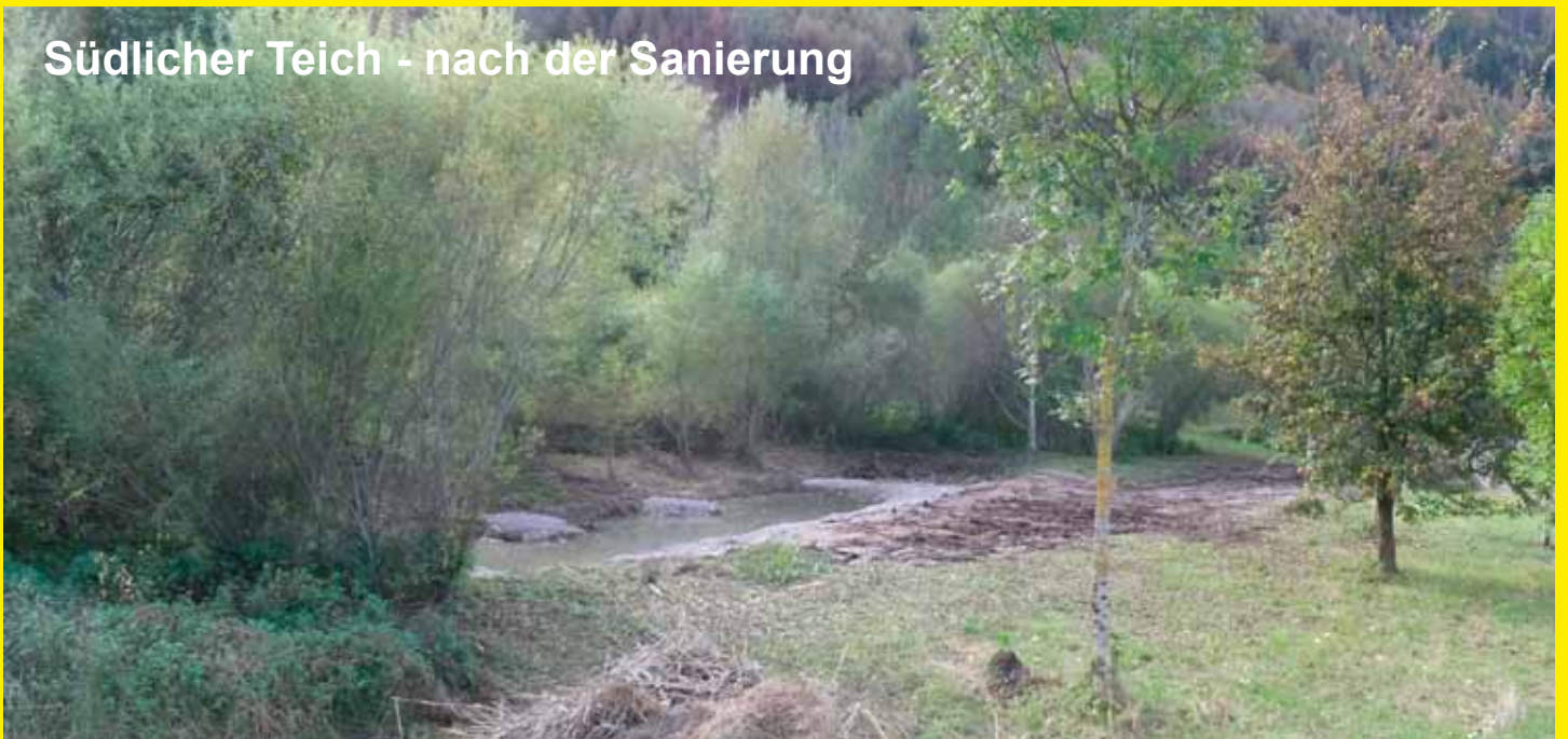
Südlicher Teich - nach der Sanierung bei Wasserhöchststand
