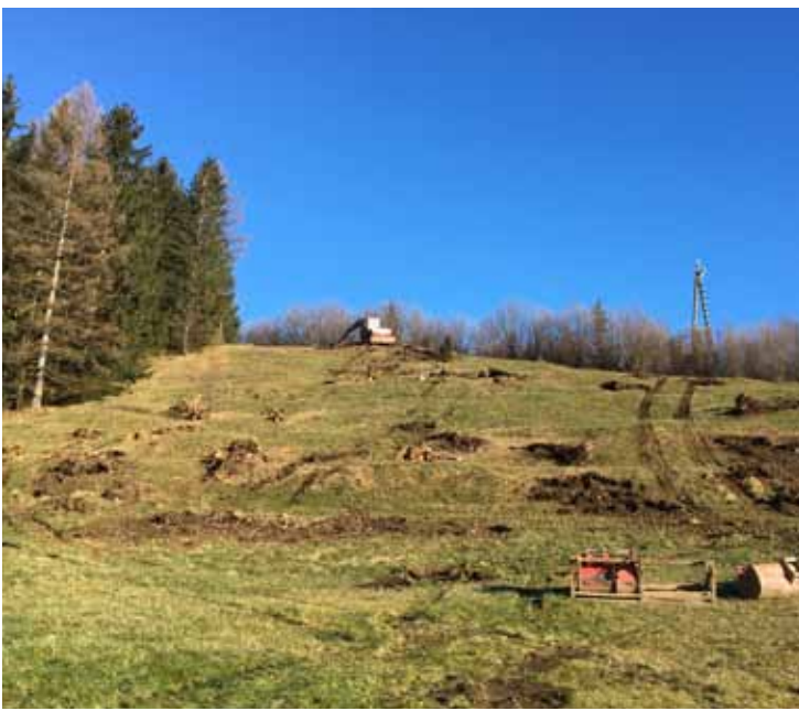
Schonende Entfernung der Wurzelstöcke durch einen erfahrenen Baggerfahrer.
