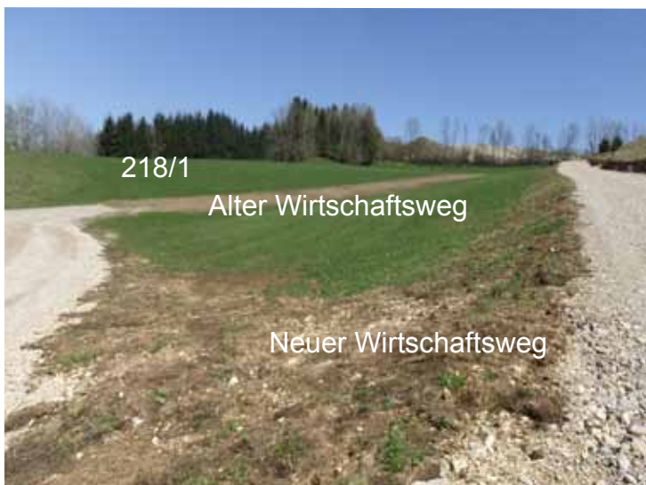
Dieses Foto entstand 2015 nach der Verlegung des Wirtschaftsweges.
