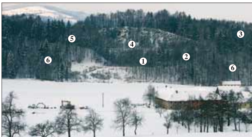
Abb. 12: Die Abbauflächen von der Kremssseite aus. 1 Untere Etage, 2 Trasse für Schrägaufzug (heute Wirtschaftsweg), 3 alte Seilbahntrasse (nun Lichtleitungstrasse), 4 Felsenband zur 5 Hochebene (heute ebenfalls mit Stromleitung), 6 ehemalige Schutthalden.
