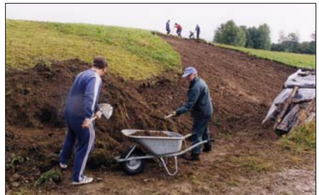
Abb. 5: Humus für die Zwischenräume und Grabenbefüllung.
