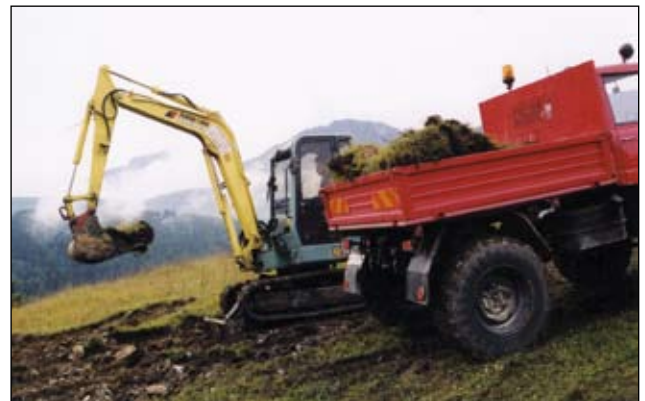
Abb. 3: Abgraben der Rasenziegel
