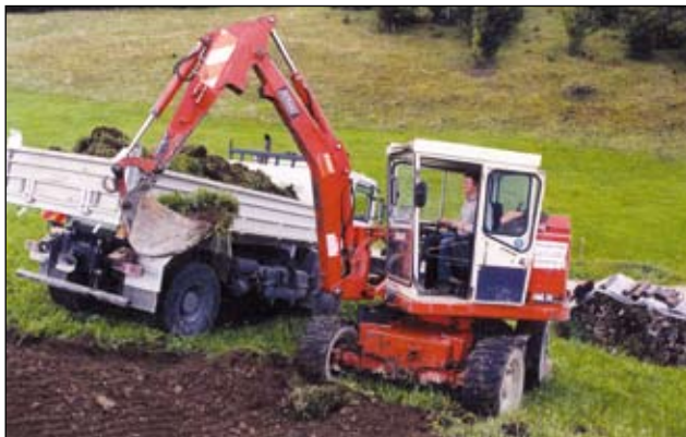
Abb. 2: Abtragung der alten Humusschicht
