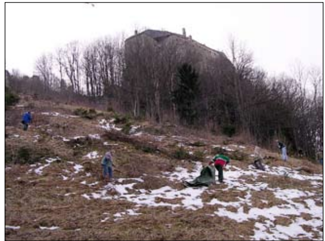
Abb. 37: Hier sind wir 2007 bei der Sanierung der sogenannten „Rastinger Leit'n“, unterhalb der Burg Altpernstein.
