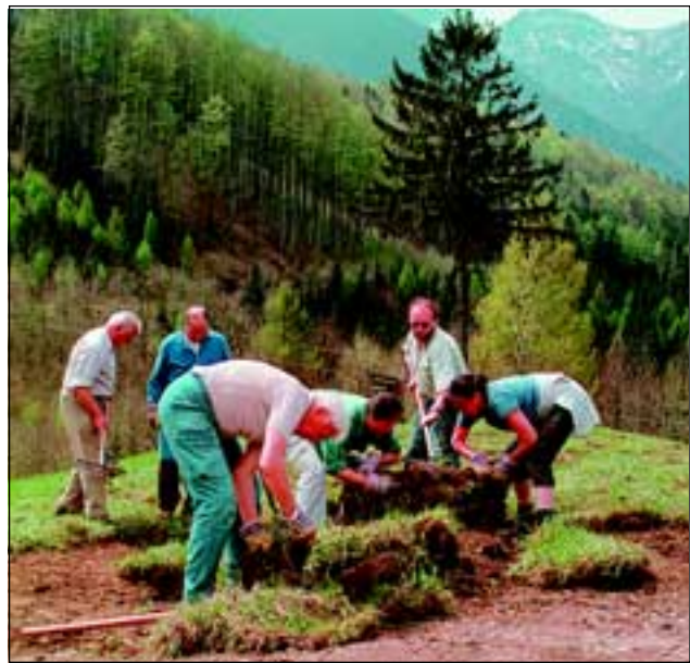
Abb. 18: Die Rasenteile wurden in Kraft raubender Handarbeit zurechtgerückt und aneinander gefügt.
