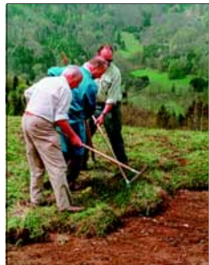
Abb. 19: Der Einsatz von Rechen zum Ziehen hat sich beim Aneinanderfügen der Rasenziegel bestens bewährt.
