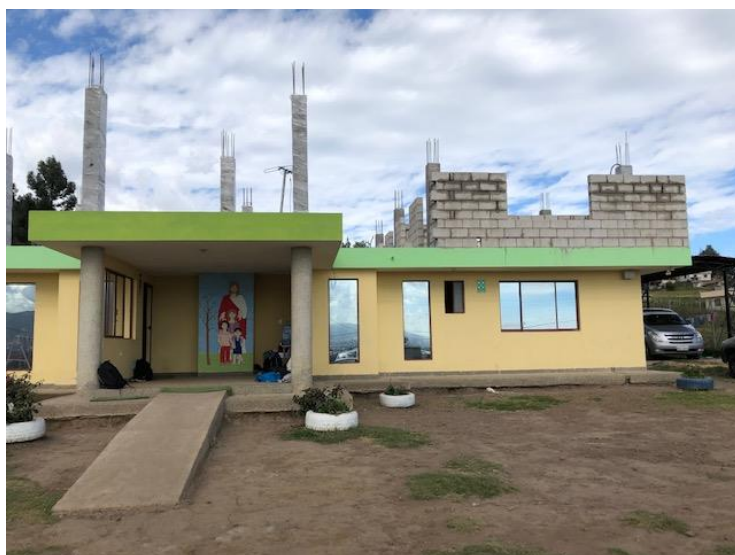
Våning två håller på att byggas.
