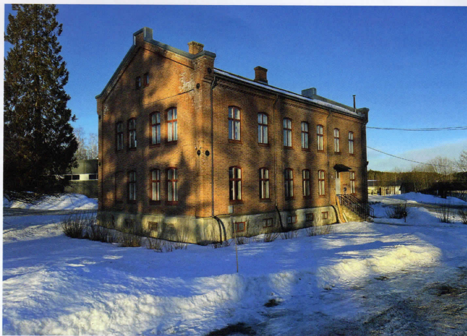
VANSKELIG: Det er de gamle kontorbyggene som er vanskeligst. Kontorbygningen fra 1912 på Kapp Melkefabrikk på Toten kan få bedre vinduer, isolasjon mot loftet og balansert ventilasjonsanlegg, men klimamessig ville det likevel vært bedre å rive det vernede bygget. FOTO: GEORG MATHISEN
