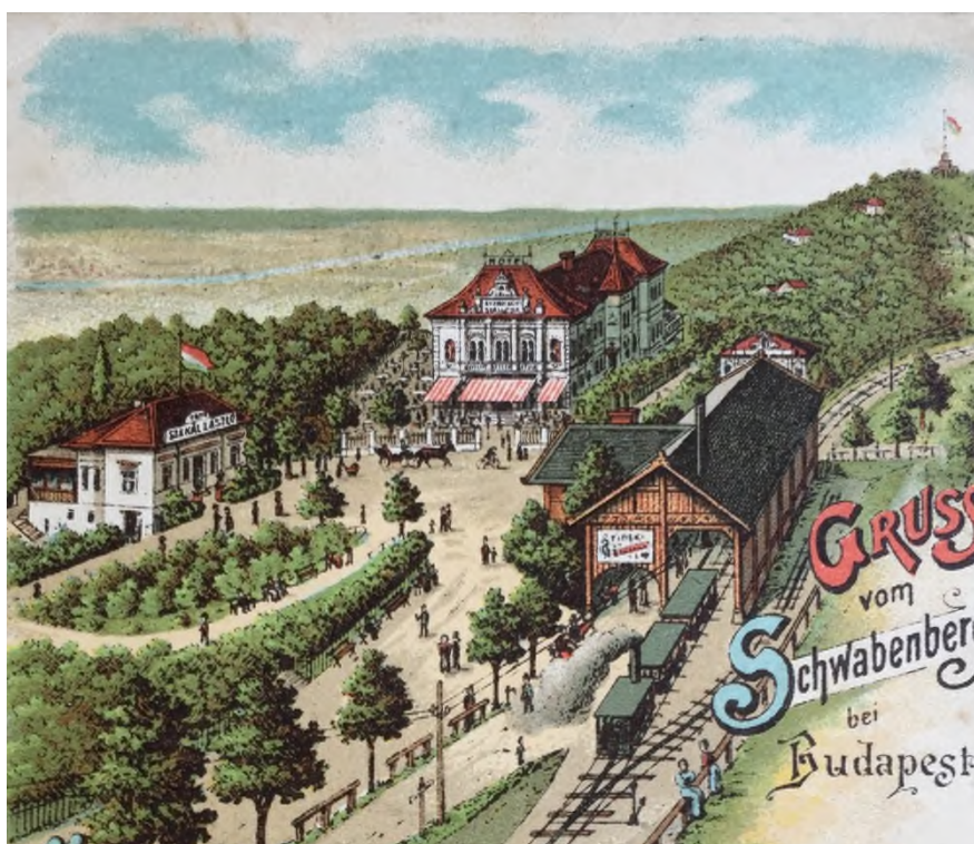
Den lille 2,8 km lange tandhjulsbane til Svabhegy blev bygget i 1874 og udvidet med 900 m i 1890. Derfor fortsætter sporet videre over bjerget her i 1896. Hotel Svabhegy ligger højt oppe med fin udsigt ned til Donau. Damplokomotivet trak to passagervogne 264 m op ad bjerget ved hjælp af et stort tandhjul, der greb fat i tandskinnen midt mellem de to køreskiner. Tegneren har ikke ydet lokomotivets teknik retfærdighed - skorsten og røg kan dog ses. 60
