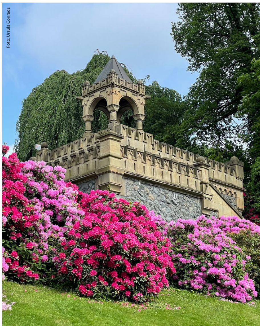
Am Eingang zum Ringeltal befindet sich die gründerzeitliche Dicke-Ibach-Treppe, die 1897 errichtet wurde. Sie ist als Denkmal geschützt.
