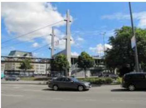
Abb. 51 Schwebebahnpylonen Alter Markt
