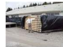
Her ligger de 20 meter lange ræster, som skal bruges til tagkonstruktionen på Træningshuset.
