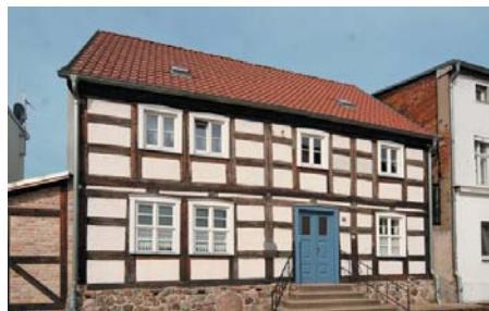
Abb.1: Nachbarbebauung in der Georg- Kurtze-Straße, Typologie und Bauweise sind mit der Bauphase I des untersuchten Gebäudes nahezu identisch.
