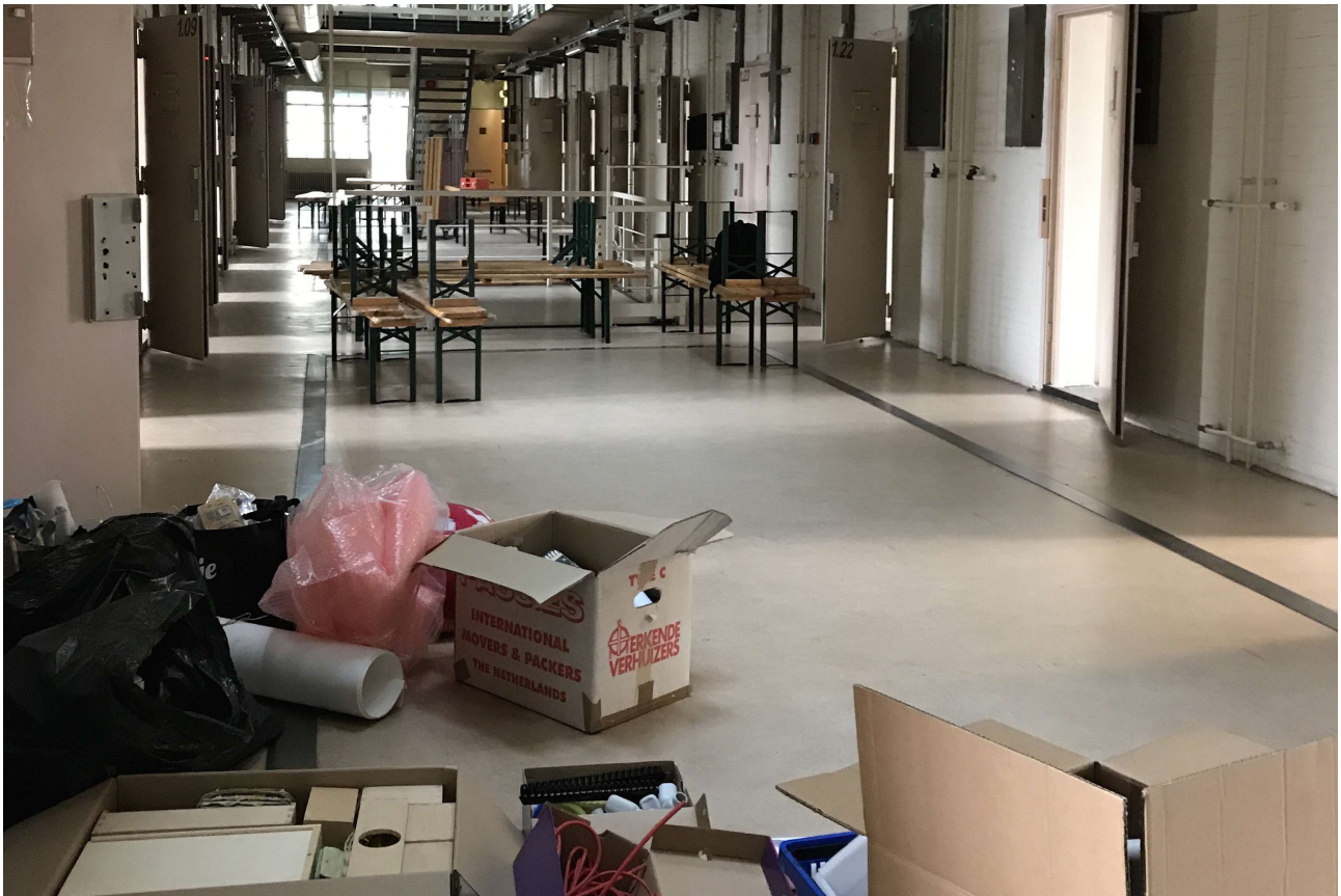
Afbeelding 2 de voorbereidingen op locatie
