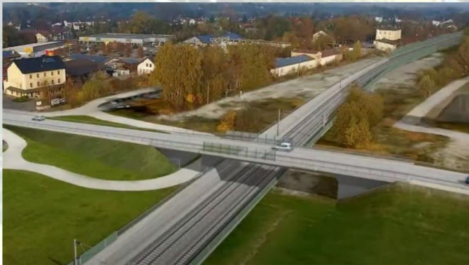
Visualisierung der DB-Lösung: Partielle Absenkung der Gleise und Anhebung der Straßenbrücke der B15 (Bildquelle: DB Netz AG, veröffentlicht im Artikel der SZ)
