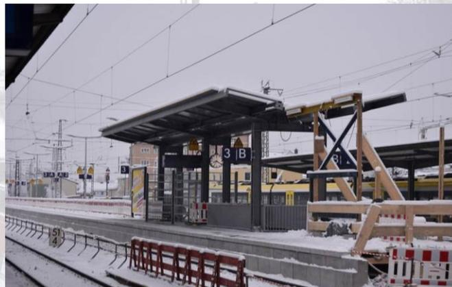
Auf dem neu errichteten Westteil des Bahnsteigs 2/3 wurde immerhin von dem Treppenaufgang bis zum sichtbaren Ende das Dach neu gebaut. Es ist kürzer als auf den noch unbebauten Bahnsteigen 1 und 4/5.
