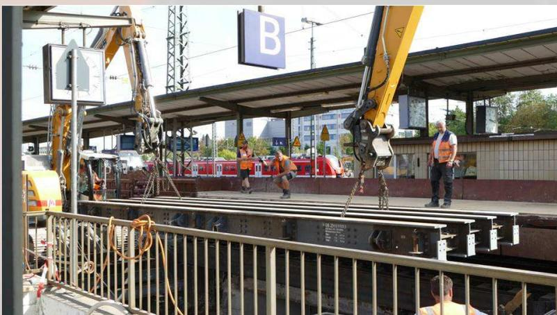
13. September: Die Behelfsbrücke für Gleis 3 über den Personentunnel wird eingesetzt.
