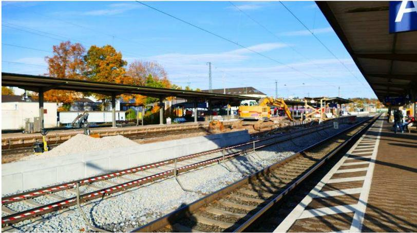
25. Oktober: Mittlerweile fehlt das Bahnsteigdach an den Gleisen 2 und 3 auf der Westseite komplett, und auch der Bahnsteig ist hier nicht mehr nutzbar. Die Bahnsteigkante, angepaßt auf die neue Höhe von 76 cm über SO (bisher: 38 cm), wird gesetzt.
