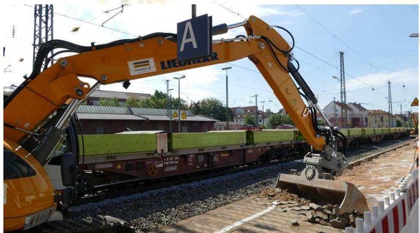
Das Bahnsteigpflaster wird entfernt und die Bahnsteigkante (ganz hinten im Bild) abgebaut. Nebenbei kam da der Bahnsteigbelag von anno damals zum Vorschein, als die Bahnsteigkante fast auf Höhe SO lag...
