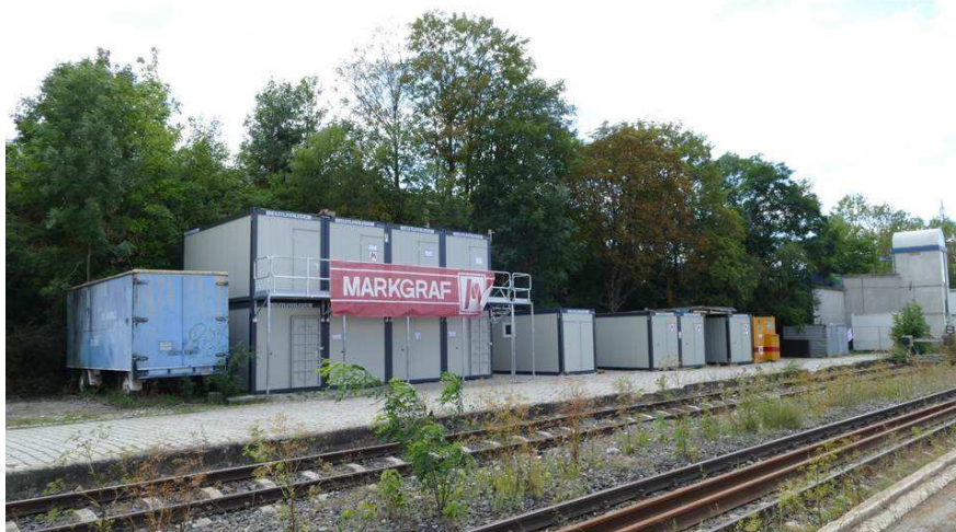
Auf der Seite der Gütergleise wurde eine Baustelleneinrichtung geschaffen... (fa)
