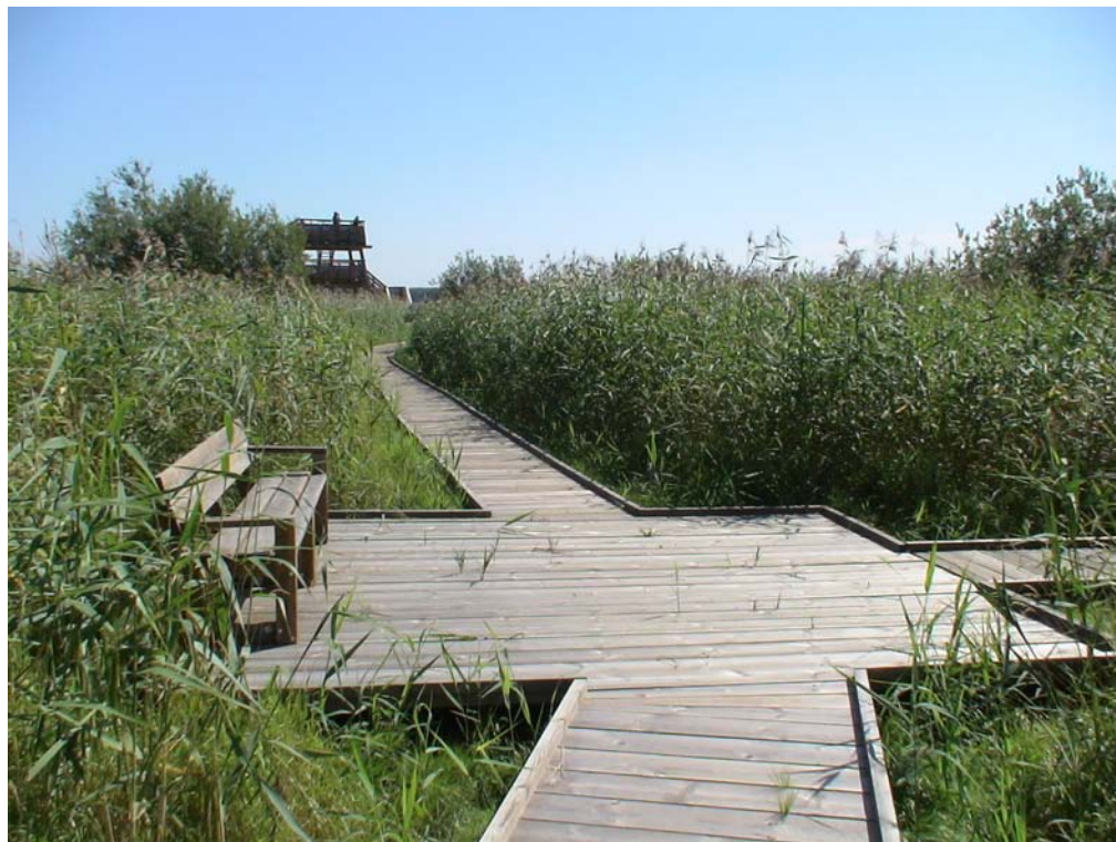
Figur 23. Fotot visar tillgänglighetsanpassad spång vid Fysingen. Bild Sigtuna kommun. Notera tvärgående bräddor och avåkningsskydd, samt plats för möte och vila.
