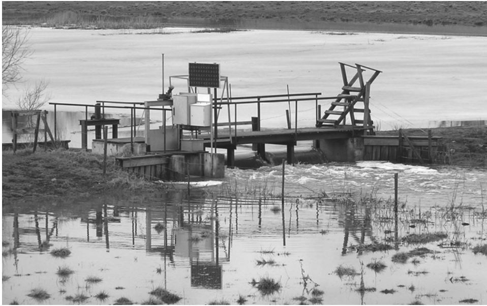
Figur 14. Dämnet vid utloppet utformades med rörlig dammlucka (t.v. i bild) samt träsättar i överfallsdelen (t.h.). Det finns också utrustning för manövrering av dammluckan via telefon (därav solfångare för elförsörjningen). Detta har dock inte gjorts färdigt, utan anordningen manövreras fortfarande manuellt. Foto: H-G Wallentinus maj 2004.
