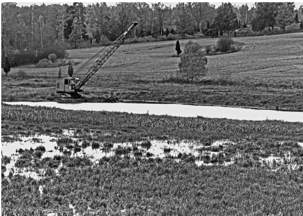
Figur 9. Slängskopa i arbete med att gräva ut dammen vid utloppet under den första restaureringen 1984/85. Foto: H-G Wallentinus, oktober 1984.
