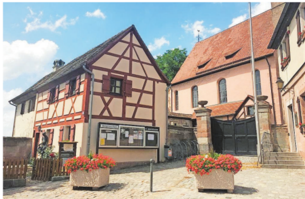
Gute Nachrichten für Großgründlach: Die Sanierung des Wächterhauses ist angelaufen. Die Renovierung soll 400000 Euro kosten.
