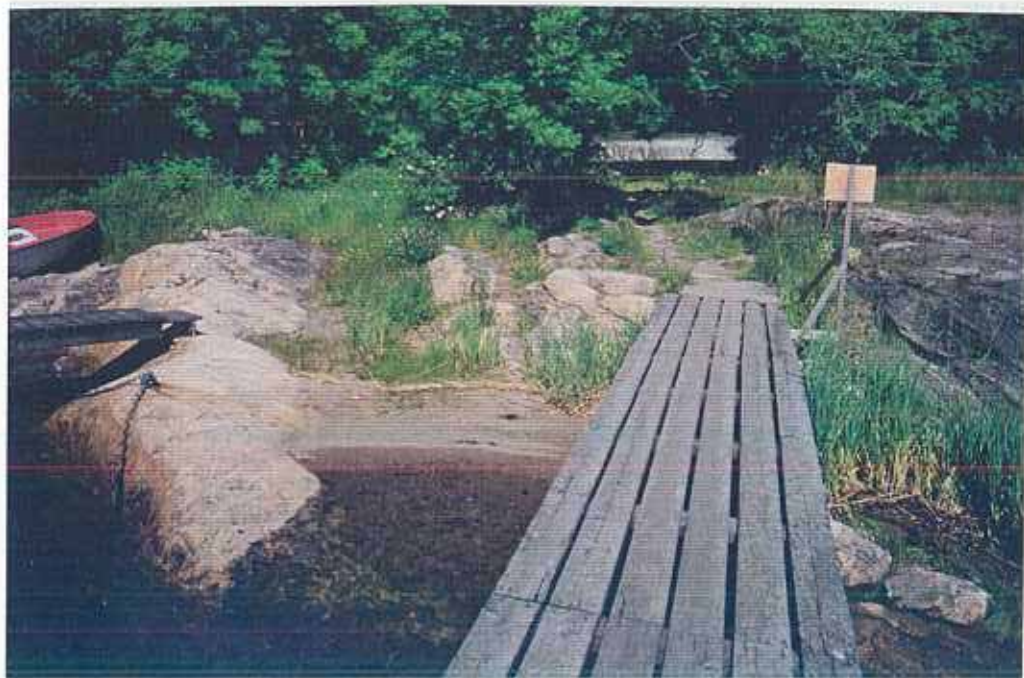
Gåsöpontonen (GP 3) med detalj på förbryggan, som går över sandstranden.
