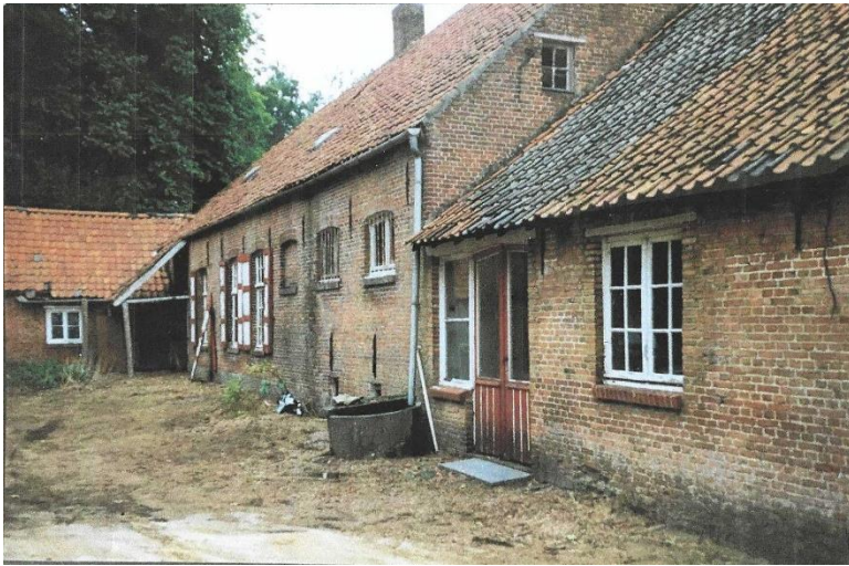
Figuur 7. De achterzijde van het woonhuis.
