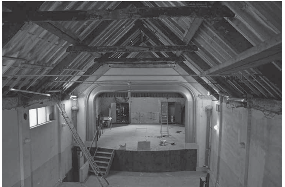
De zaal, het podium, het balkon en de kelder werden volledig ontmanteld. Binnen afzienbare tijd krijgt de zaal zijn oorspronkelijke glorie terug.
