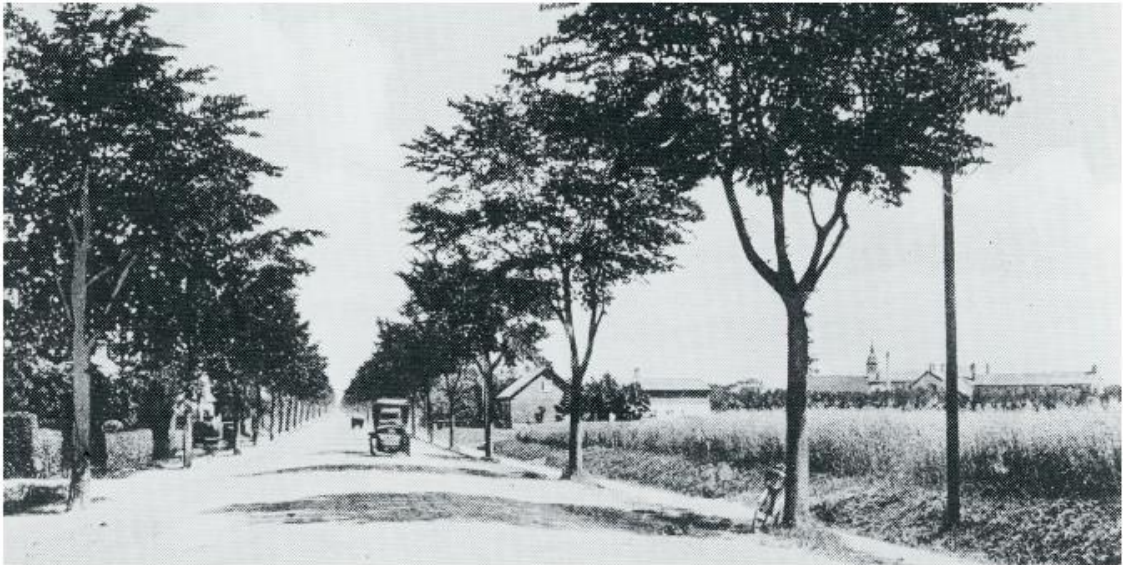
Roskilde Landevej gennem Vridsløselille 1916. Statsfængslet ligger til højre (Funch og Tofte).
