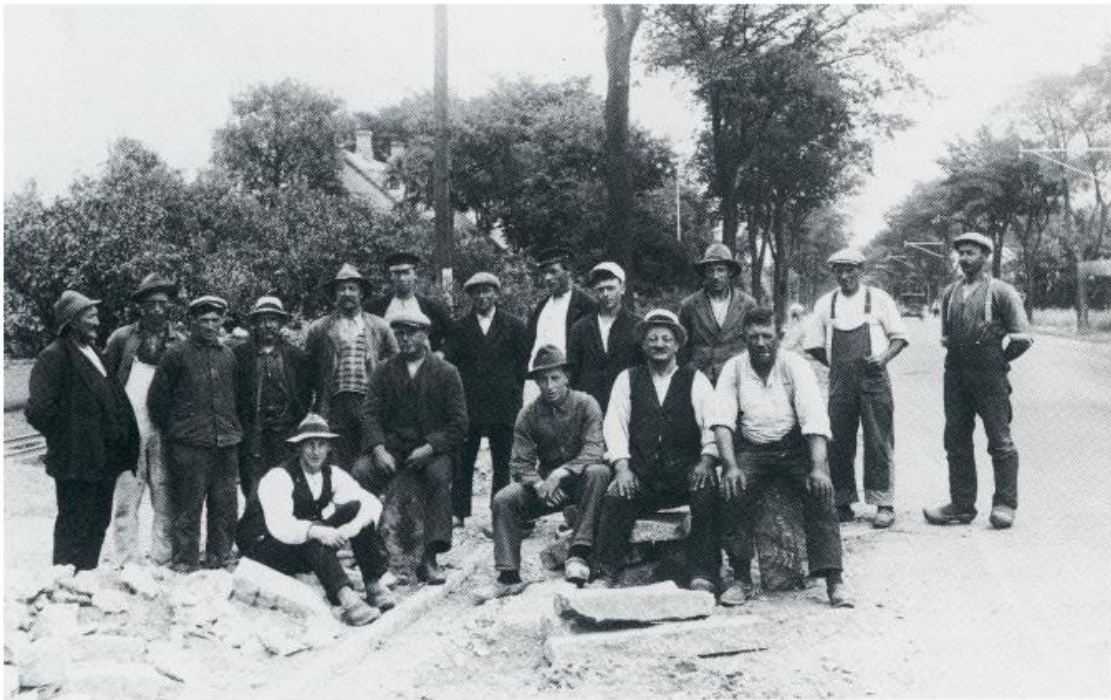
Arbejdere ved Roskildevejens udvidelse gennem Vridsløselille 1921-22. (Funch og Tofte).
