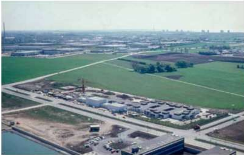
Luftfoto af Nordmarksskolen under opførelse. I forgrunden ses Rådhuset og den ubebyggede Albo-grund (sommer 1975).
