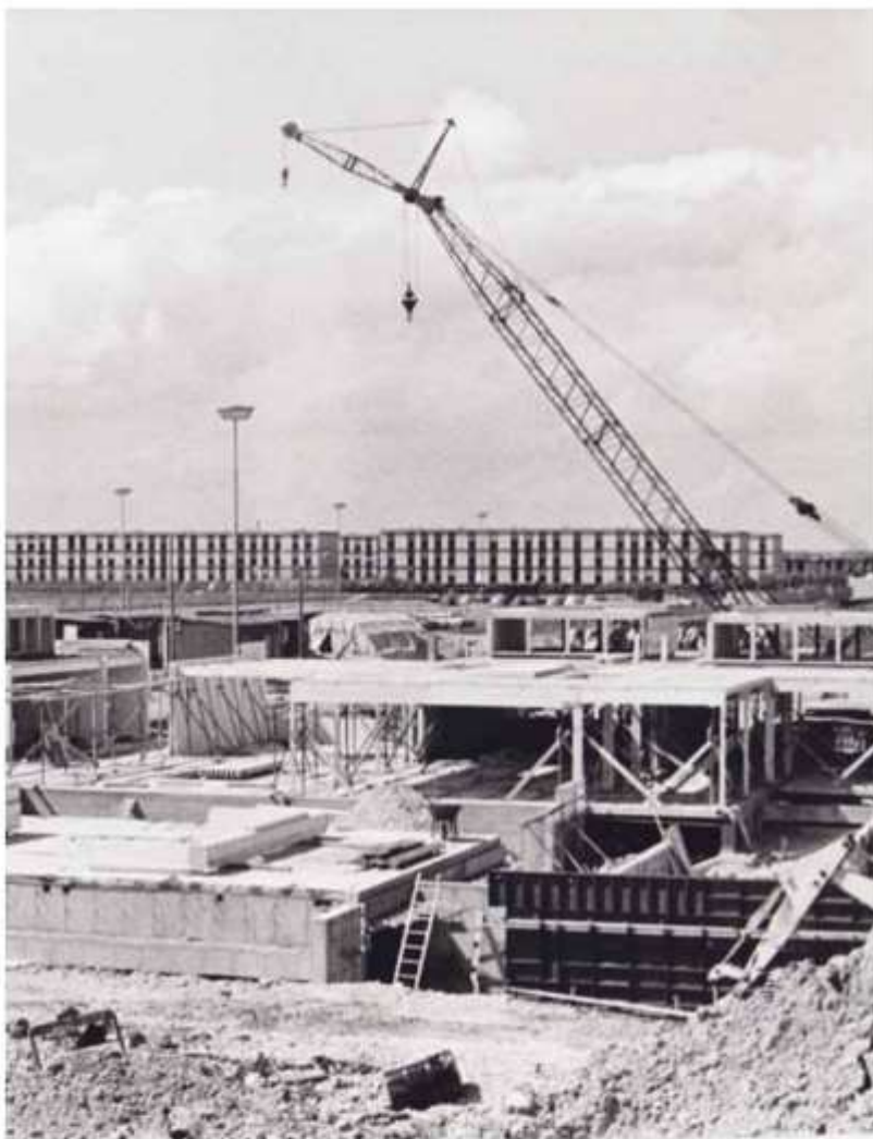
Skolen under opførelse i 1971. I baggrunden ses Nordmarkshave – opført 1966.
