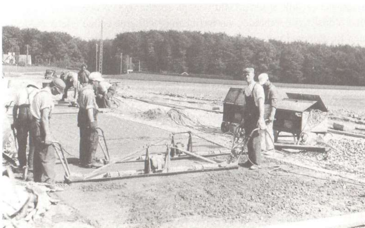
Støbning af betonvej, her Strandvejen sidst i 1930. Betonvejen var slidstærk, men kostbar at anlægge. Et problem, som amtet stadig døjer med, var sammenføjningerne. Foto: Fra chaussé til motorvej, 2001.
