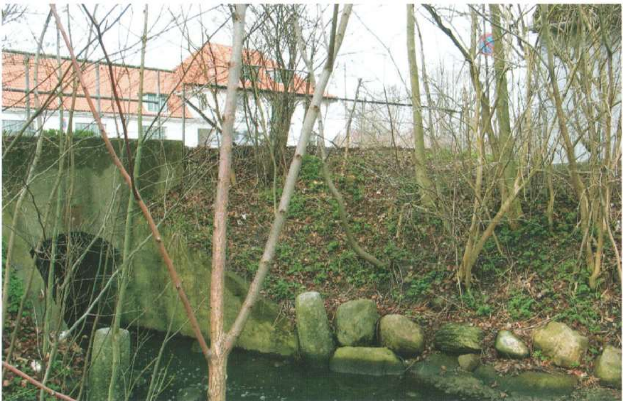
Broen under Roskildevej ved Roskilde Kro (Foto: Inge Andersen, 2006)
