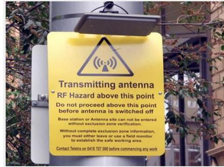
Sendeleistung dieser Basisstation: ~ 280 W (Mikrozelle): 1.000 µW/m<sup>2</sup> nach 150 m
