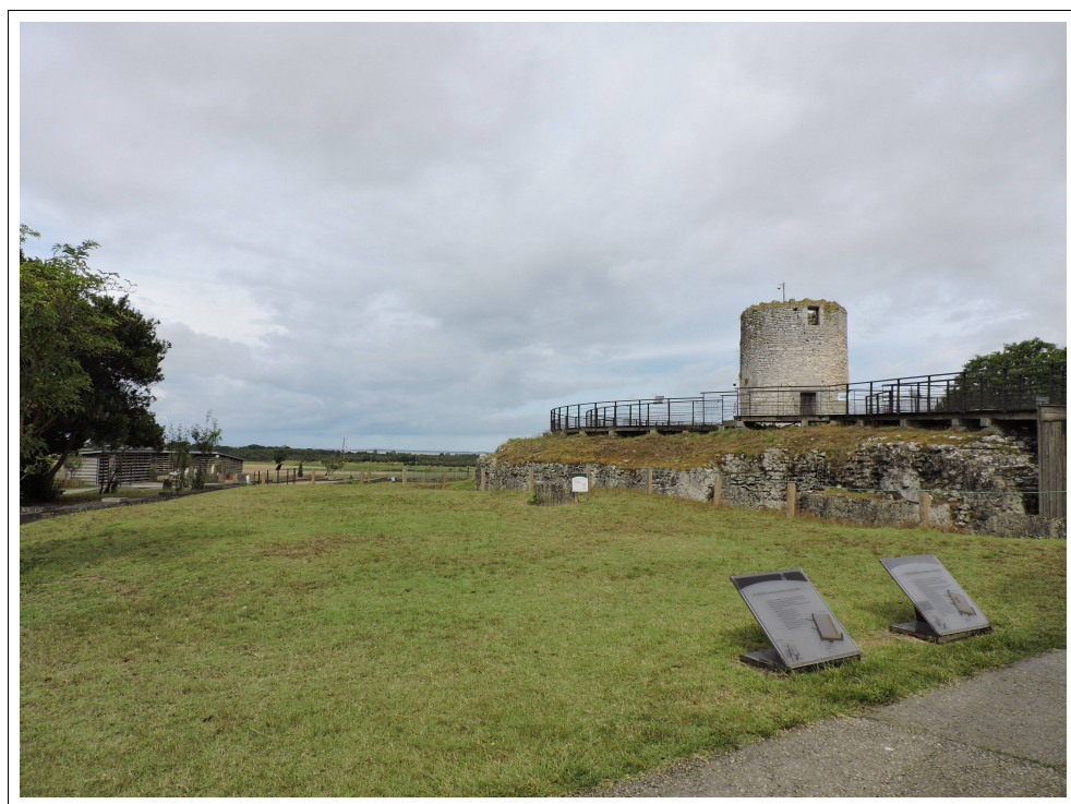
Le Moulin du Fâ et les fondations du fanum
