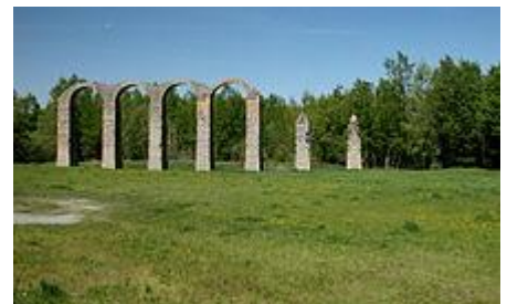
7 - Resti acquedotto romano
