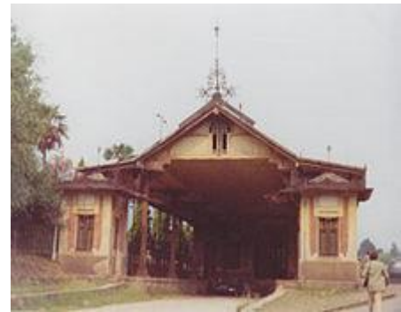
8 - Stazione ferroviaria degli anni Sessanta
