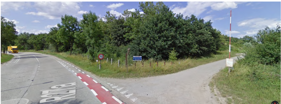
Ambachtenlaan en (natuur)gebied afgedekt en bebost gipsstort, met daarachter de bezinkingsputten van de suikerfabriek
