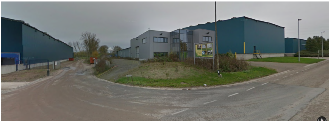
Locatie aansluiting segment I op Industriepark
