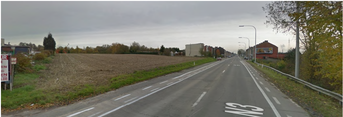
zicht op achterliggend open ruimtegebied binnen deelzone Leuvenselaan
