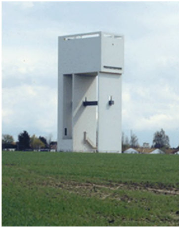
nieuwe watertoren t.h.v. ringwegsegment IV
