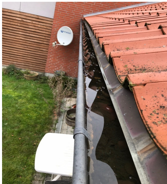
Tilstoppet tagrende. Mulighed for overløb / råd og svamp i spær mm.
