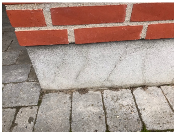
Mindre revner i sokkel. Revner vurderes at være af kosmetisk art.
