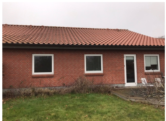
Tagkonstruktionen er i god stand og har en lang levetid på ca. 60-70 år
