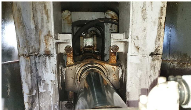
Besiktiget sliteklosser, teleskop sylindre, wiretrekk fester og slanger til teleskop.
