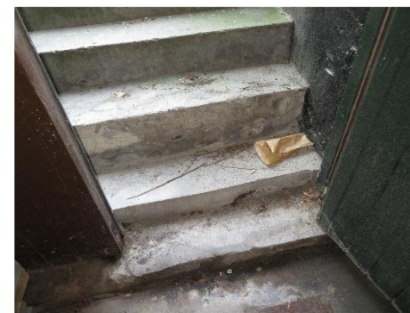
Kældernedgang mod gården
