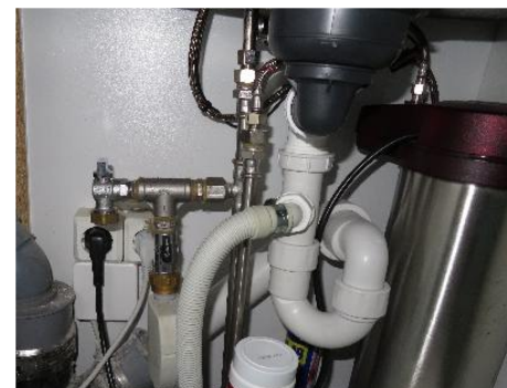
Nye rustfri stålør i køkken
