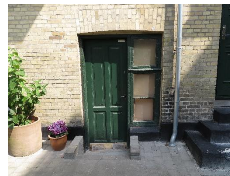
Oprindelig kælder- dør med sideparti
