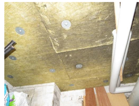
Efterisolering i kælder
