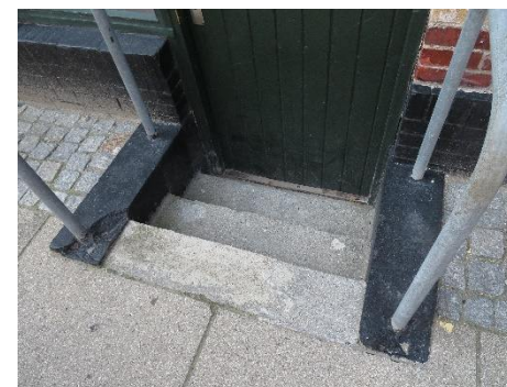
Kældernedgang mod gaden
