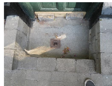
Gulv afløb i kældernedgang
