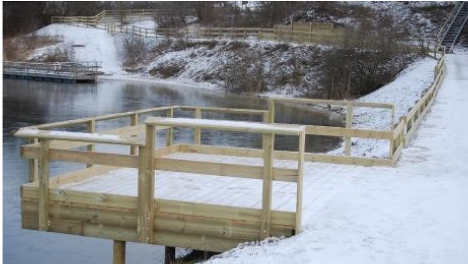
Nybyggd fiskebrygga och gångväg vid Sallerupsdammen.
