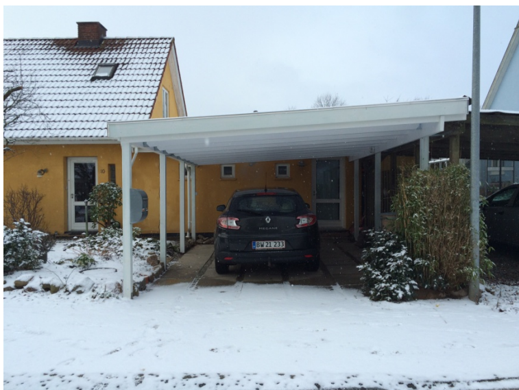
Et eksempel på en åben carport
