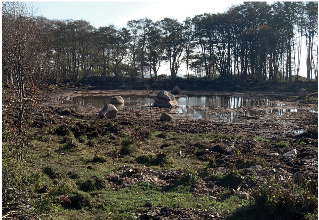
Figur 14 A och B. Från schaktningsarbetena på flytsvaltinglokalen oktober 2018. Foto: Kjell-Arne Olsson.
