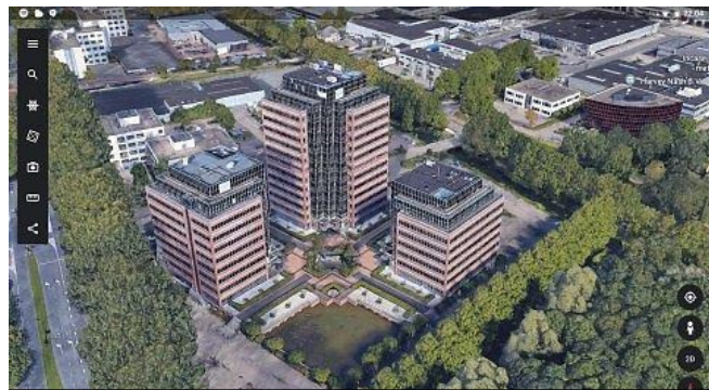
Op de open plek (voorgrond) kan een woontoren komen
