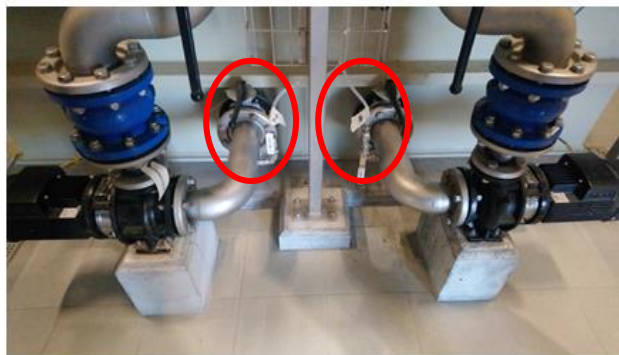
Doseringsrør - her de små slanger før pumper
