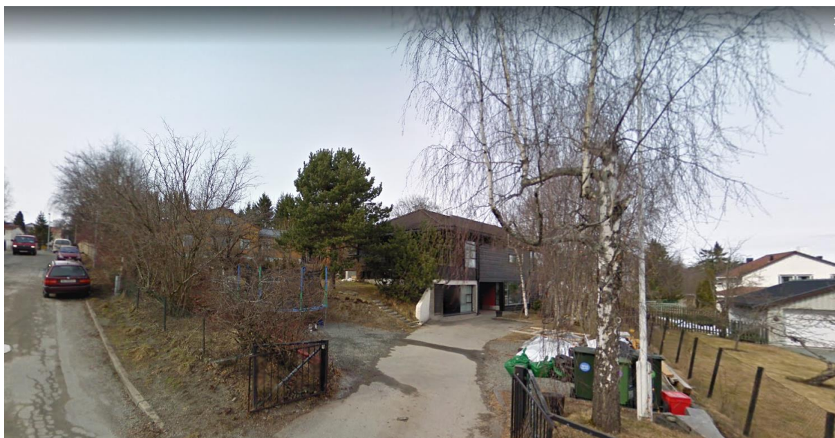
Figur 7: Eksisterende bygg innen planområdet. Fagertunvegen 3-5 er det mørke huset midt i bildet og Fagertunvegen 7 er det gule huset bak.
