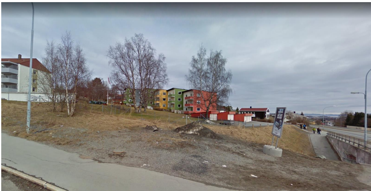
Figur 5: Blokker i Breidablikkveien. Planområdet er bak det hvite stakittet til høyre på bildet.
