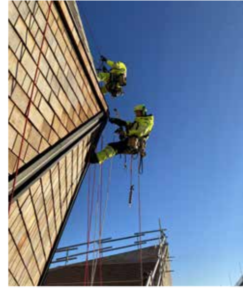
Plåtarbete, Kupolen, Universeum
