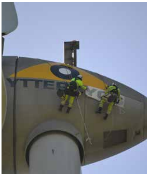
Montering av logga, Vindkraftverk
