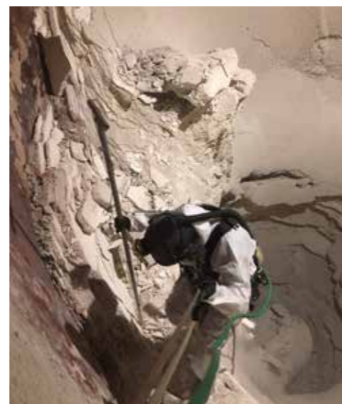
Borttagning av löst material, Silo
