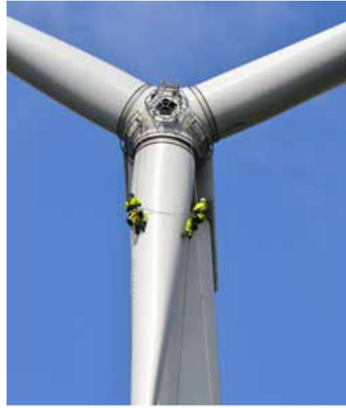
Bladinspektion vindkraft
