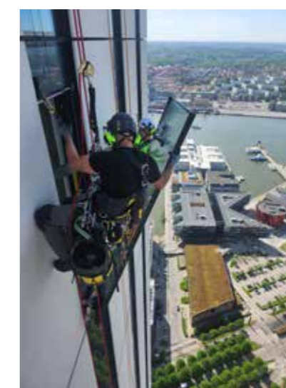
Fönstermontage Karlatornet, Göteborg
