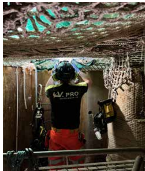
Montering av skyddsnet
