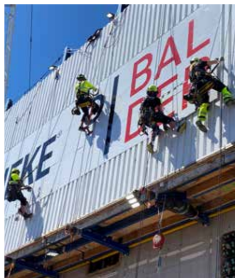
Monteringsarbete skyltar, Karlatornet
