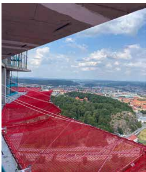
Montering av nedfallsskärmar, Karlatornet
