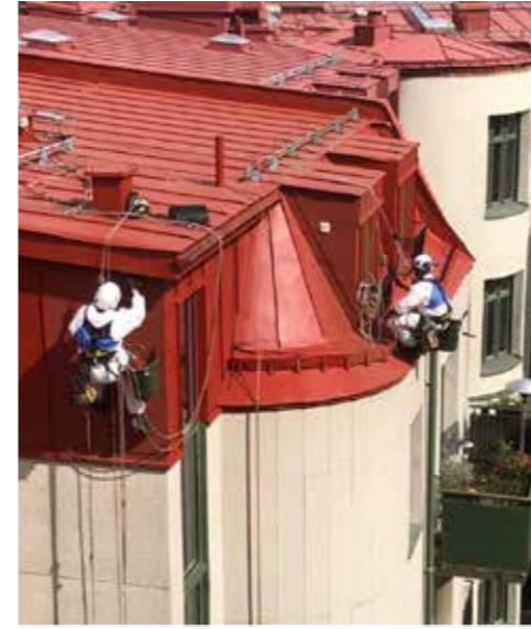
Rostskyddsmålning av tak
