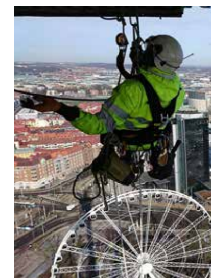
Plåtarbete på Atmosfear Liseberg, Göteborg
