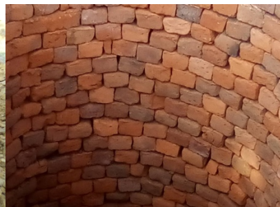
Der Bau der Zisterne für die Toiletten
