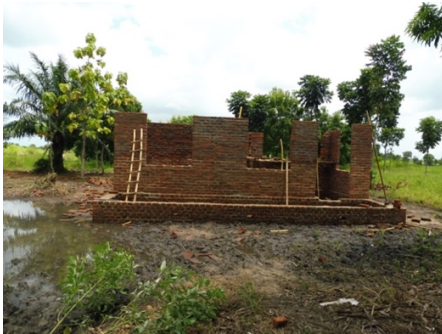
17. Februar 2020 Der Ringanker wird gemauert
