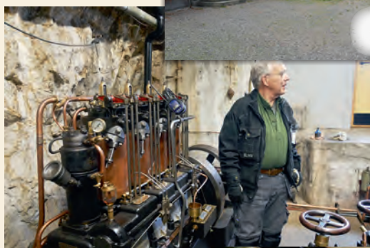
Inne i Kraftstationen som verkligen är värd ett besök. De Gentlemän som har arbetat i årtal med renoveringen är förtjänta av mer än beröm.
