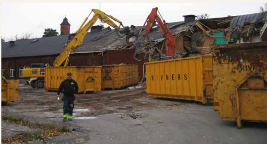
Gamla matsalen/bataljonsförrådet under rivning.
