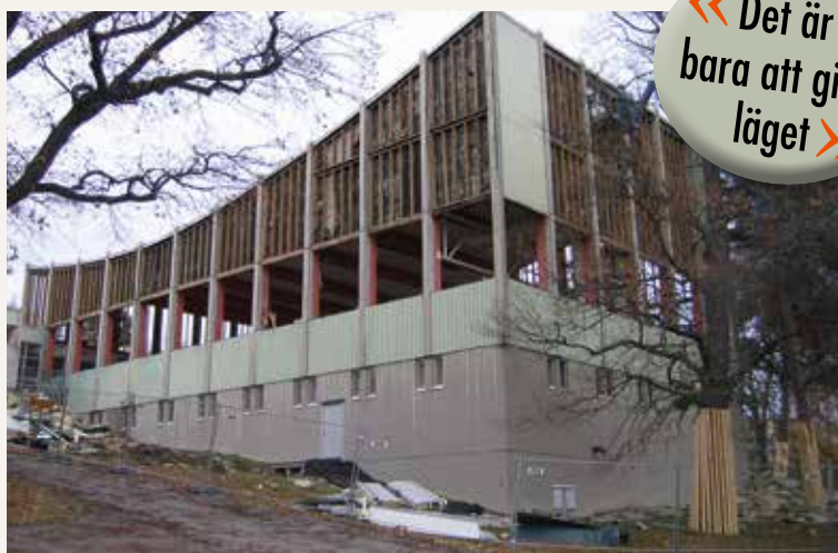
Vattenutbildningshallen under rivning.
