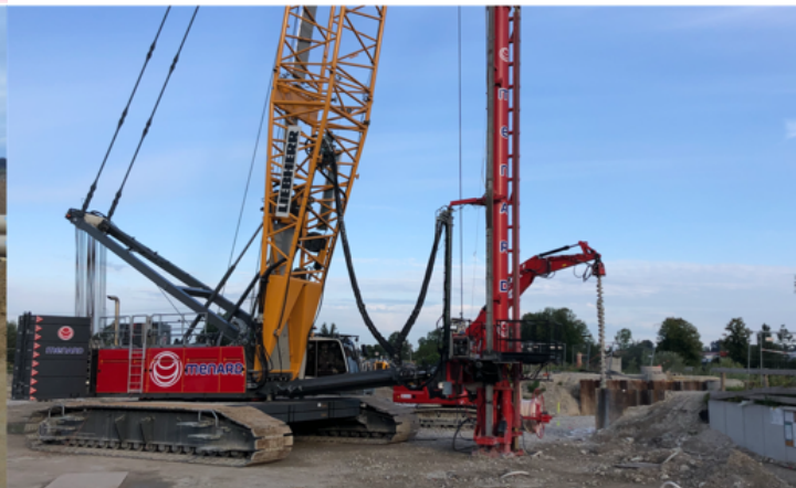
Bohrarbeiten für Trassenfeiler (Am Beispiel Westumgehung)
