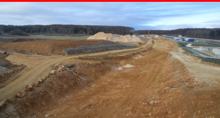
Trassenverlauf neben der A8 (Gut zu sehen: die Breite der Baustelle)
