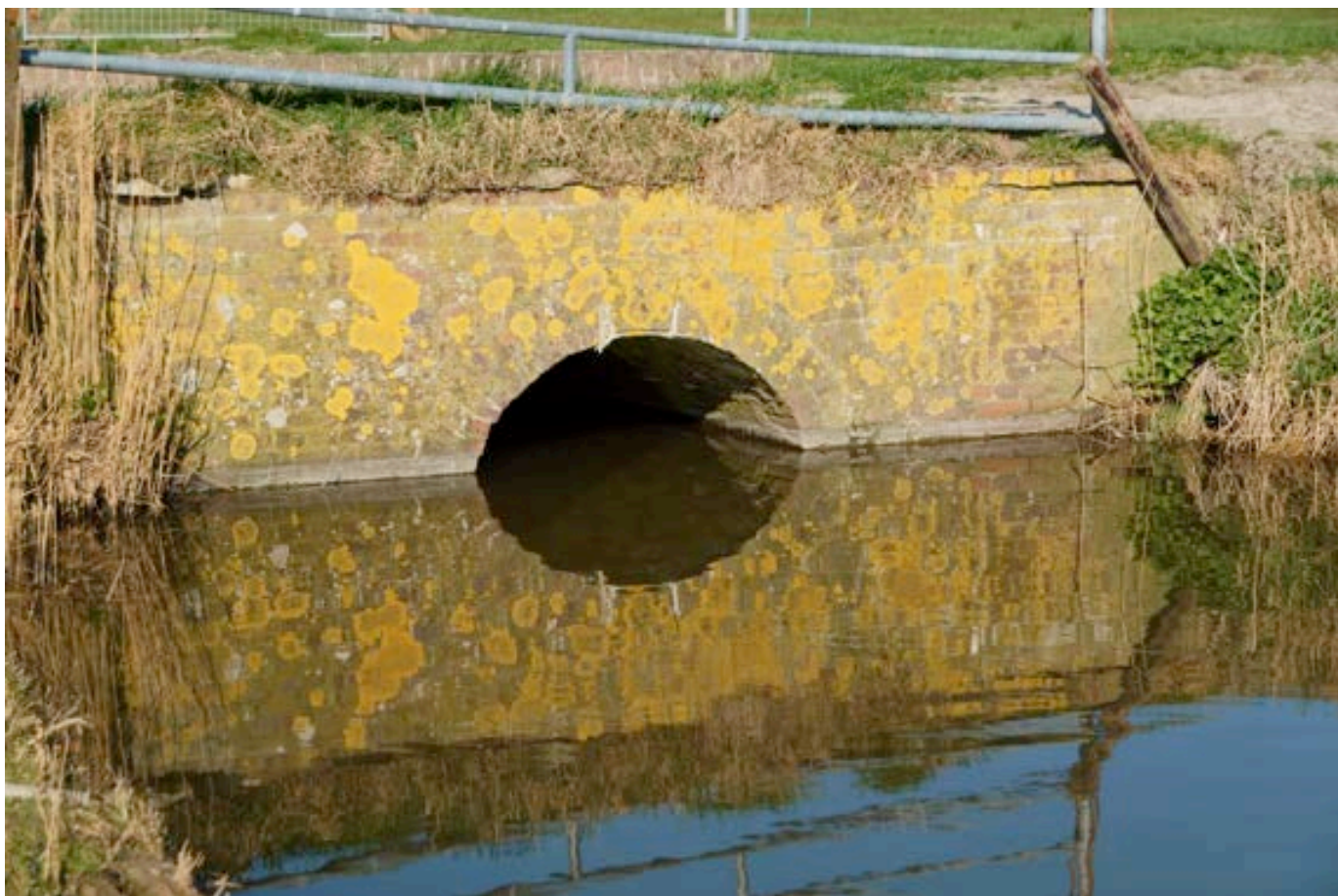
Foto van de eerste dam vanaf de Provincialeweg gezien, maart 2021
