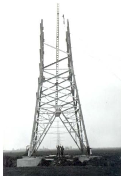
Afb. 5 220 kV hoogspanningsmast in aanbouw. Foto FB, uit het archief van de HKU
