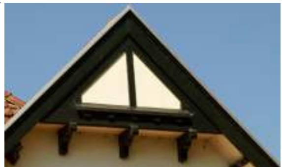
Cordonlijst op klossen, een uitspringende lijst of band langs een gevel om verdiepingen te markeren
