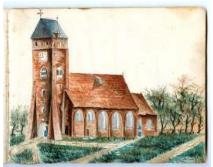
Afb. 4 De kerk van Haren, circa 1850-1860. De zadeldak-toren werd bij een restauratie vervangen door de huidige achtkantige spits. Collectie Groninger Archieven (1536_6811_15)
