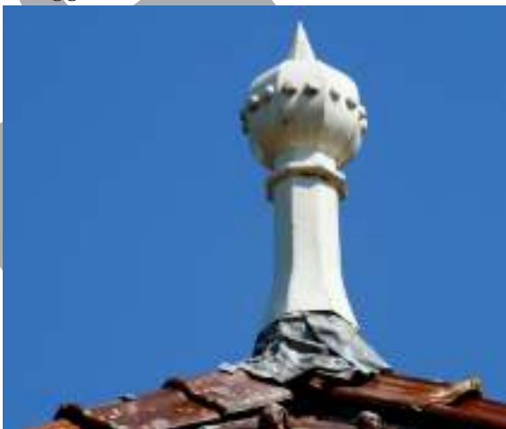
Piron, een ornament op een markant punt van een bouwwerk, zoals een dak of gevel, vaak in de vorm van een taps toelopende zuil met een bolvormige figuur
